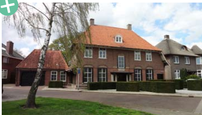
Bijgebouw passend bij hoofdgebouw en ondergeschikt.
